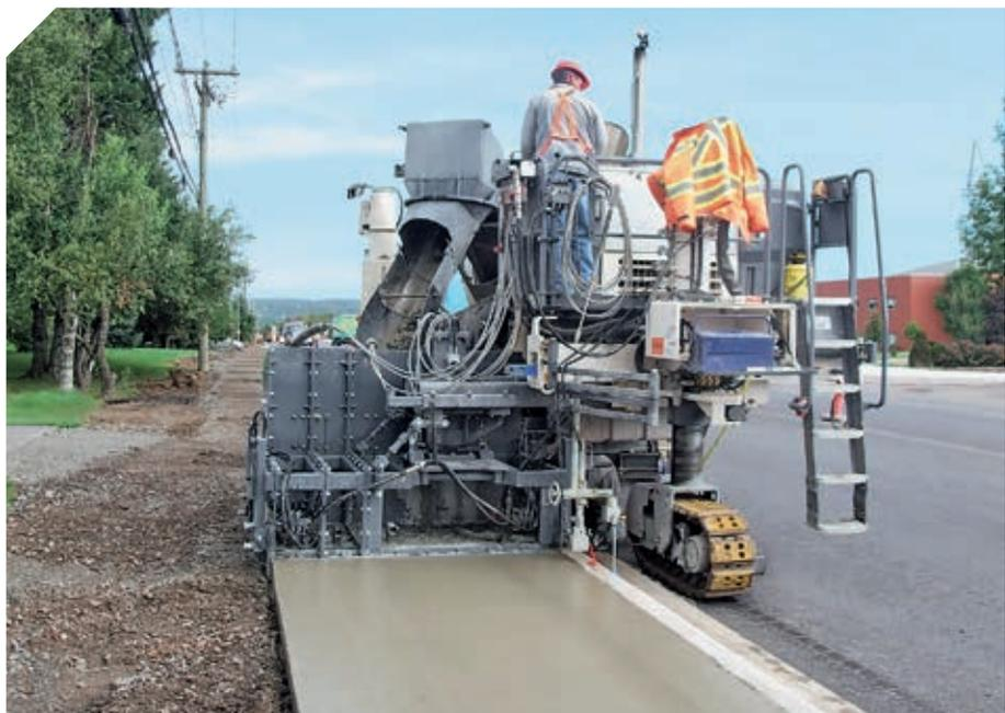
▣ La souplesse de positionnement du coffrage glissant, des trains à chenilles et de l'alimentation en béton élargit énormément le champ d'applications de la SP 15/SP 15i.
