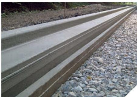
◀ Réalisation de profils de bordure-caniveau complexes
