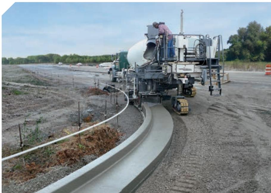
➤ Trimmer, alimentation en béton par convoyeur ou vis sans fin, vibrateurs électriques ou hydrauliques sont autant d'options qui permettent d'augmenter considérablement la souplesse d'utilisation de la machine.
