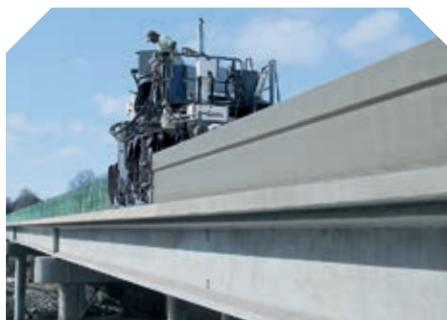
▲ Application spéciale « Parapet » pour une haute résistance au franchissement : une pose aussi bien à droite ...
