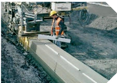
▲ Pose d'un caniveau à fentes pour l'écoulement des eaux pluviales
